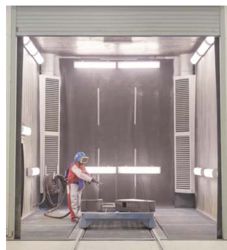
Камерная пневматическая установка очистки с ручным управлением оператором
